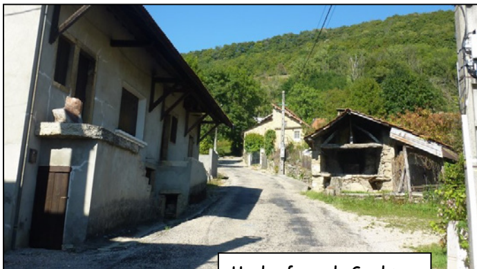
Un des fours de Soudon
