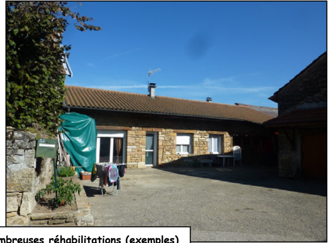
Nombreuses réhabilitations (exemples)
